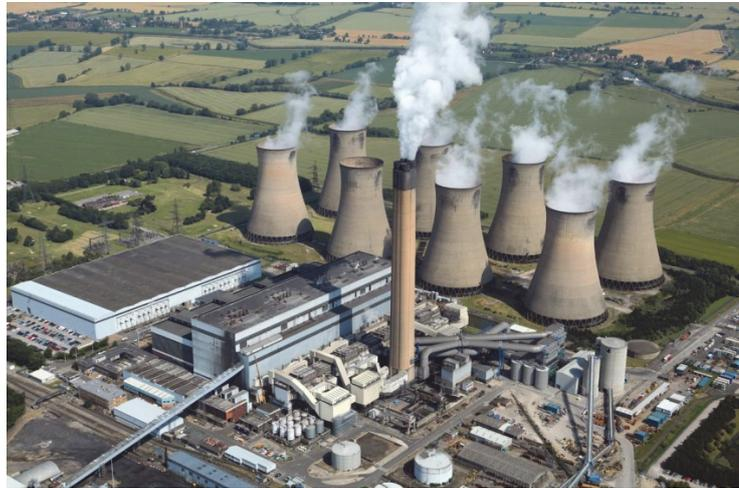
Различают ТЭС и теплоэлектроцентрали (ТЭЦ). Первые вырабатывают только электрический ток, а вторые не только генерируют электричество, но и дают тепло в системы отопления и горячего водоснабжения.
